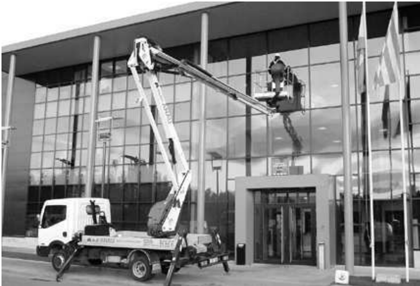
Trabajos de operarios de Multianau. s.e.
